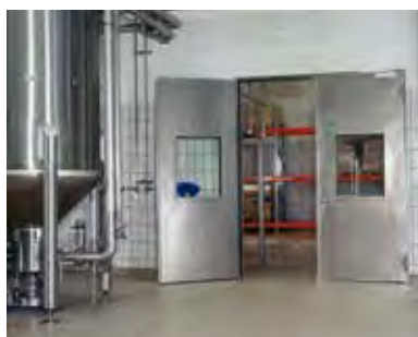
Feuerschutztür, marmorierte Oberfläche, in einem Brauereibetrieb.
