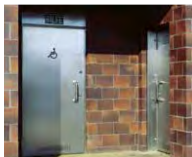
Öffentliche WC-Anlage auf einem Rastplatz.
