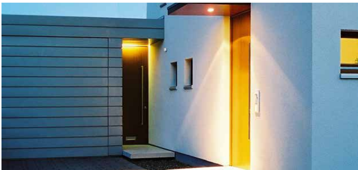
Flächenbündige Sonderlösung mit waagerechten Zinkblechen.
