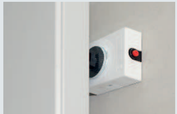
90° Offenstellung mittels Haftmagnet
