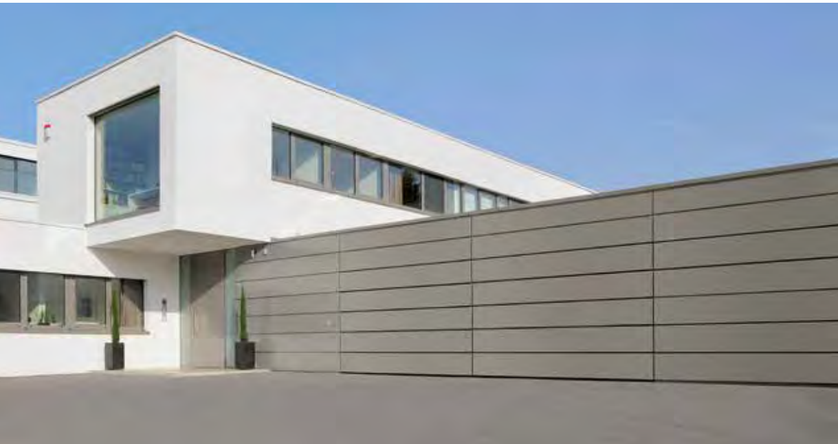
Bauseitige Beplankung mit Aluminium-Verbundplatten
