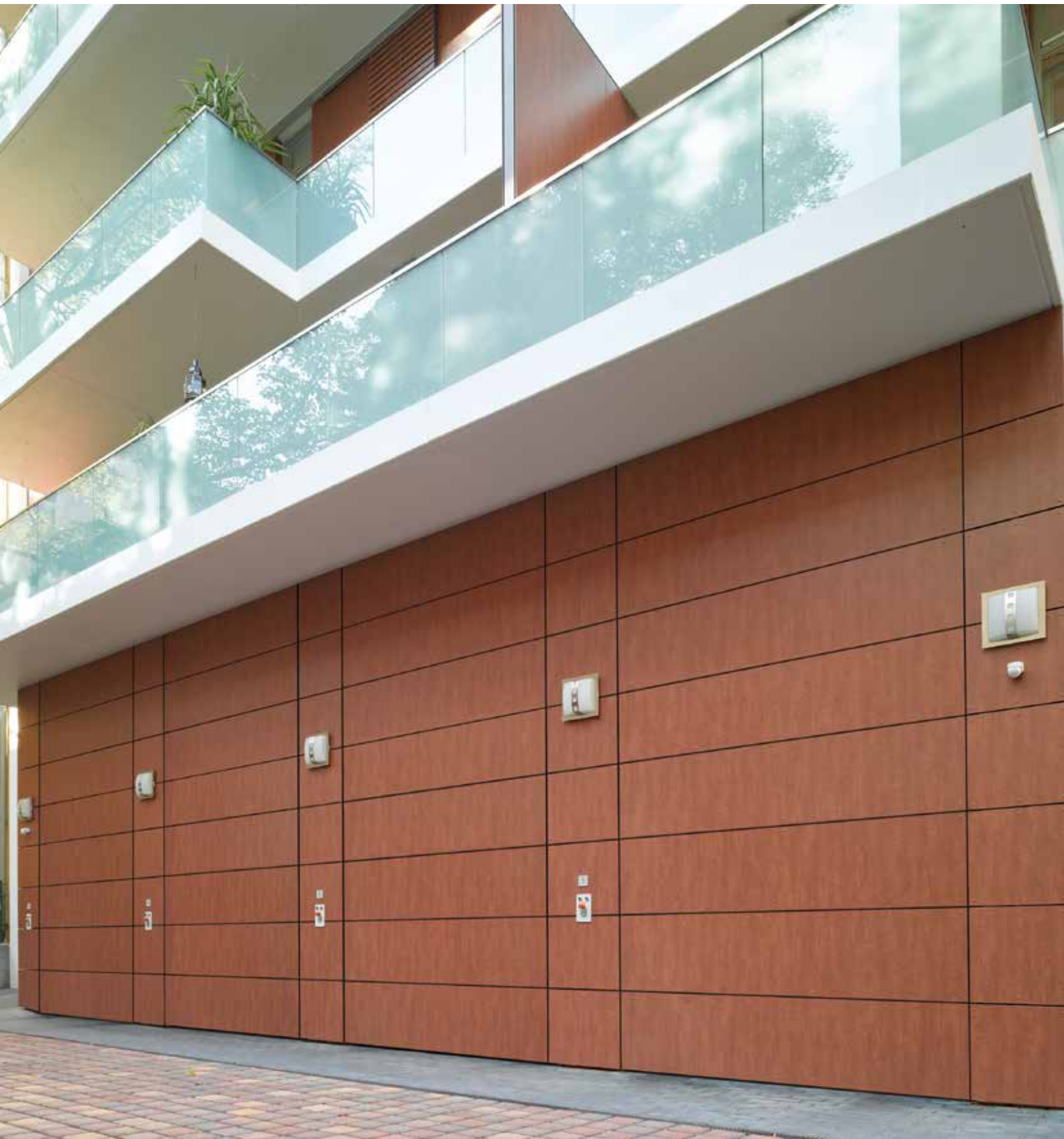
Bauseitige Beplankung mit Schichtpress-Holzplatten
